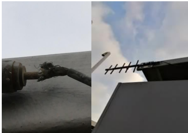
Ilustración 2. Evidencias deterioro cable de antena
