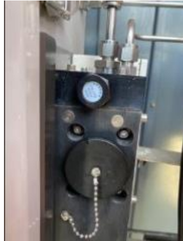
Ilustración 4. Filtro desecante en buen estado
