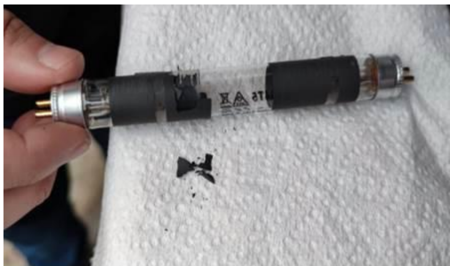
Ilustración 4. Cambio de lámpara UV
