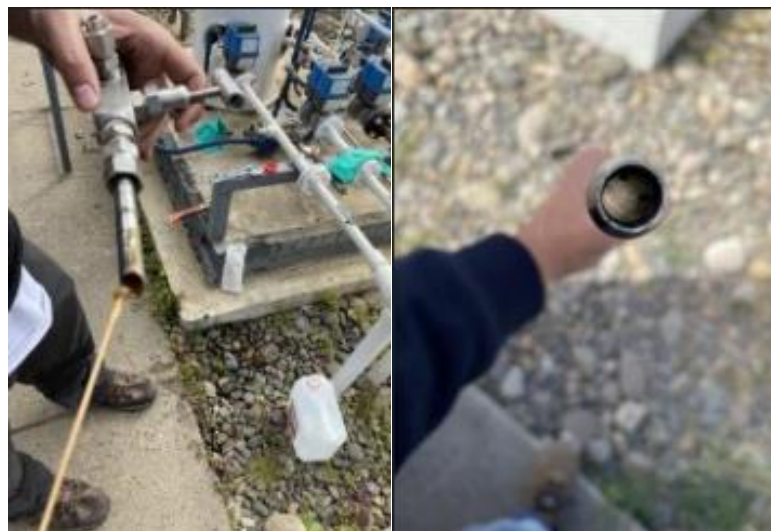
Ilustración 1. Escasa evidencia de carbón activo en trazado neumático
